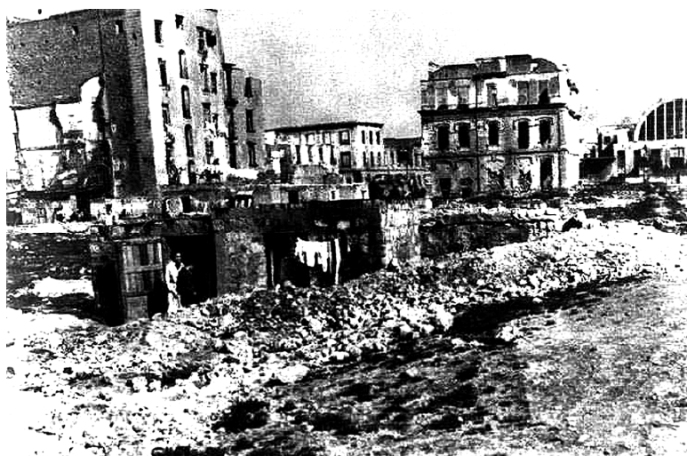
Imagen nº 10. Vista de la Via Marina, una de las grandes calles de Nápoles, totalmente destruida por los bombardeos aliados.
